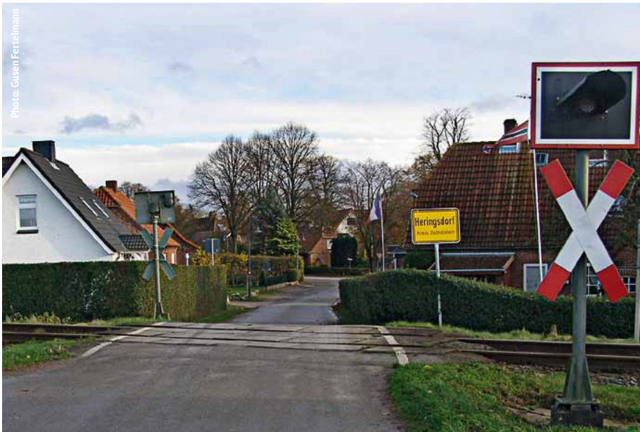
Hinter jedem noch so unscheinbaren Bahnübergang, wie hier in Heringsdorf an der Bahnstrecke Lübeck-Puttgarden, steckt ein komplexes Genehmigungsverfahren, das durch das Eisenbahnkreuzungsgesetz geregelt wird.
