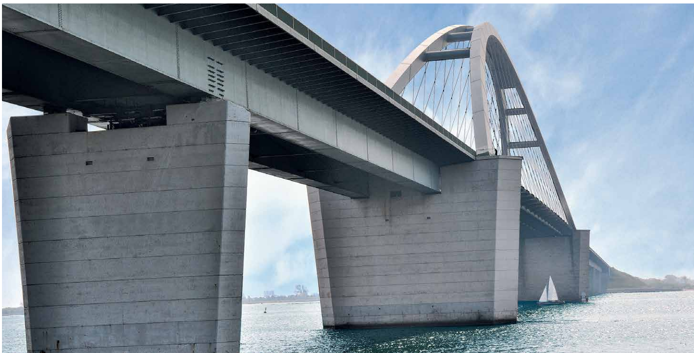
Die Fehmarnsundbrücke verbindet die Ostseeinsel Fehmarn mit dem Festland. Sie liegt auf der sogenannten Vogelfluglinie zwischen Deutschland und Dänemark
