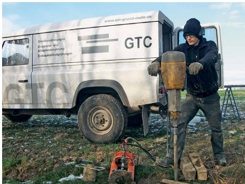
Zur Planung gehören auch Baugrunduntersuchungen. Dabei wird die Beschaffenheit des Bodens entlang der möglichen Trasse untersucht. Insgesamt finden 400 Bohrsondierungen in einem festgelegten Korridor statt
