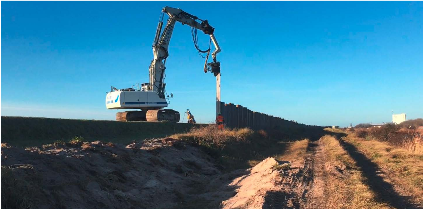
Bauvorbereitende Maßnahmen in Rødbyhavn: Hier entstehen der Arbeitshafen und die Produktionshallen für die Fertigbauteile des Absenktunnels.
