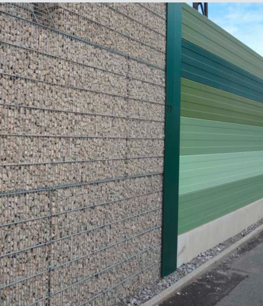
Schallschutzwand kombiniert mit Gabionenwand
