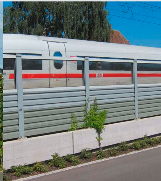
Schallschutzwand mit durchsichtigem oberen Einsatz
