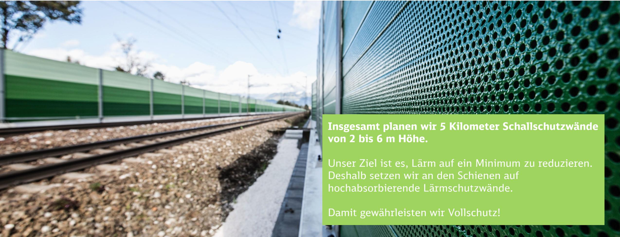
**Insgesamt planen wir 5 Kilometer Schallschutzwände von 2 bis 6 m Höhe.**
