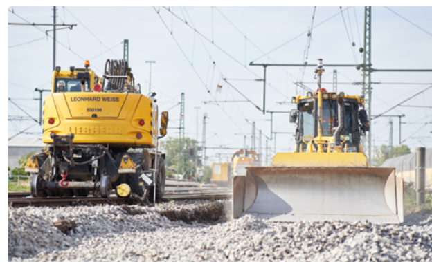
Für den zweigleisigen Ausbau und die Elektrifizierung der Strecke werden neue Bodenbeläge aufgetragen.
