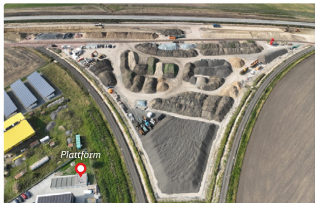
Von der Plattform des DB-Infocenters auf Fehmarn (Severitenkamp 13) haben Gäste einen sehr guten Blick auf die Baustelleneinrichtungsfläche am Gleisdreieck in Burg.
